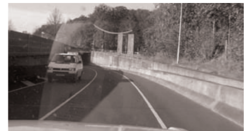
tunnel tussen Leek en Nietap
