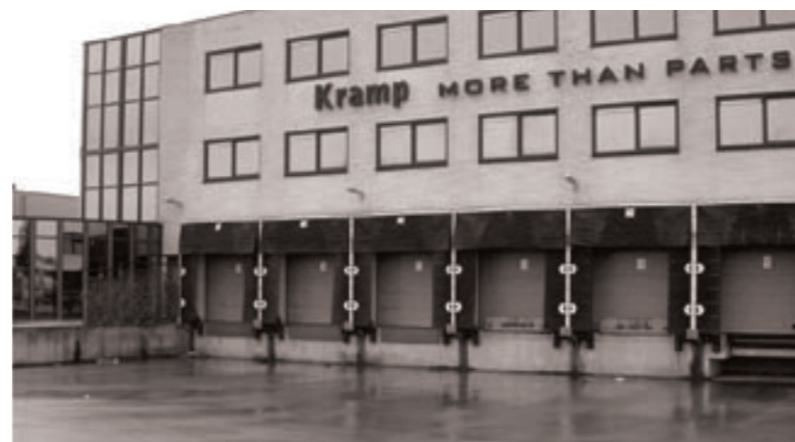
Tolbert, loadingdock- bedrijventerrein op verkeerde locatie
